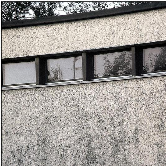
Bild 2: Fehlende Dachüberstände in Verbindung mit ungeeigneten Beschichtungen ergeben ein hohes Risiko für Algen- und Pilzbefall.
